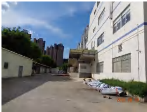
C 栋西侧厂区过道
