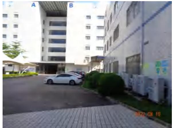
测试中心分析东侧厂区过道
