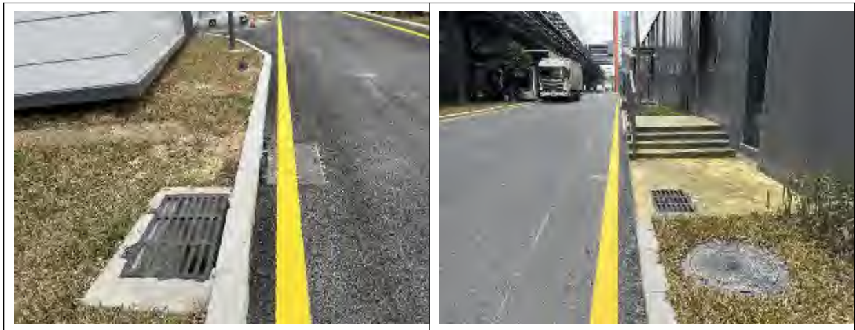
图 3.5-1 已建工程区工程措施（部分）
