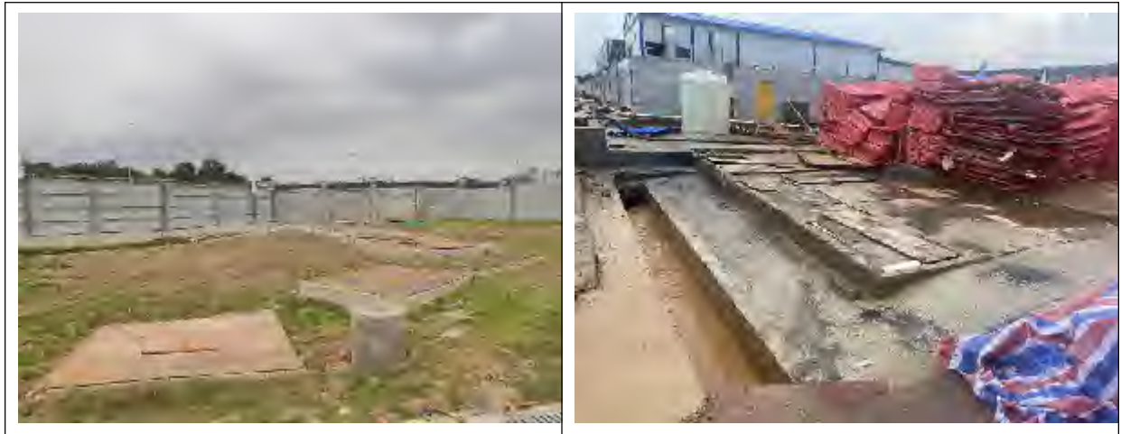
图 3.5-3 已建工程区施工期间临时措施照片（部分）
