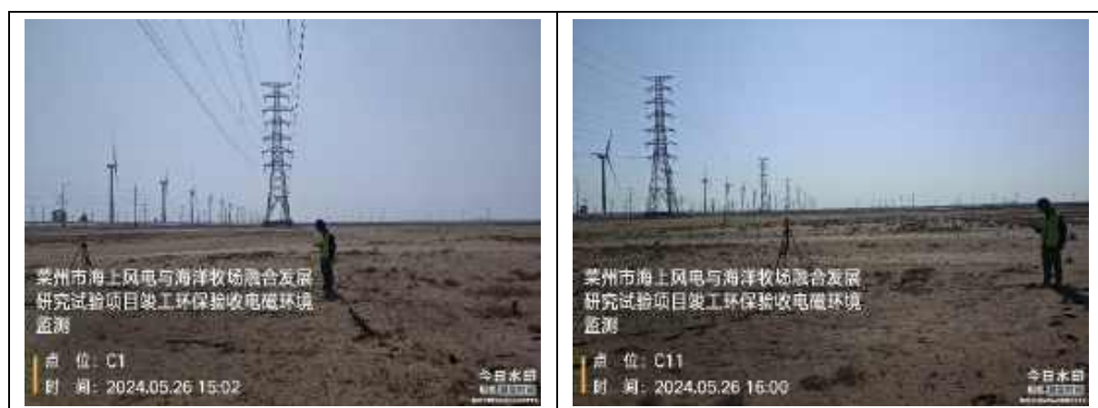
图 10.2.2.2-7 架空输电线路电磁环境现场监测照片
