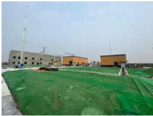
陆上升压站地面绿网覆盖
