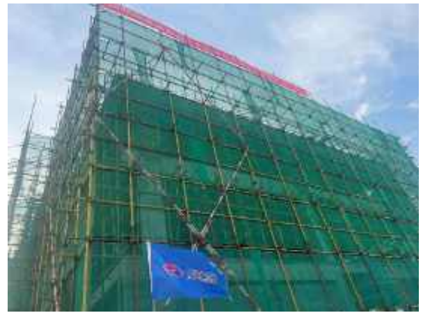
陆上升压站建筑体绿网覆盖
