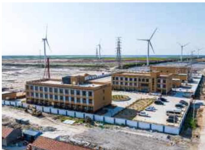
陆上升压站全景
