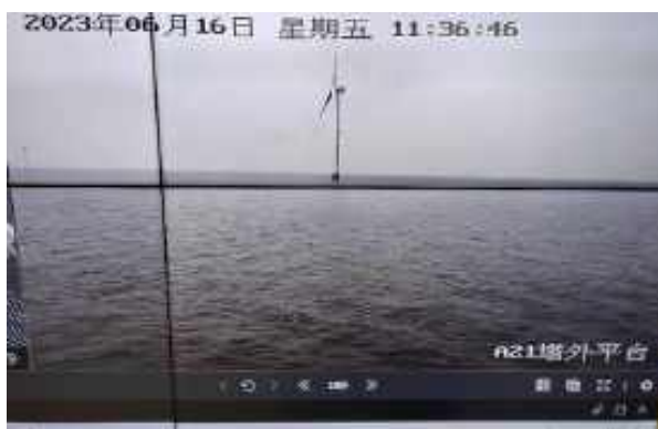
单个风机现场照片
