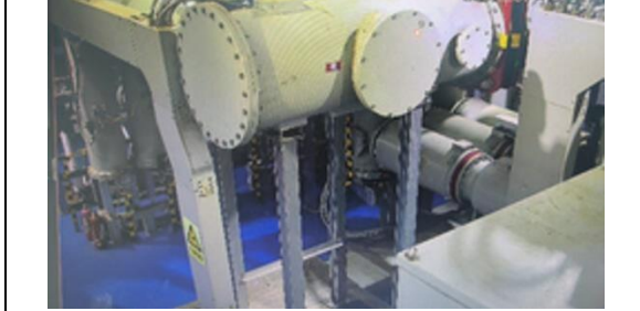
升压站设备的底部与承重基础间加垫隔振材料
