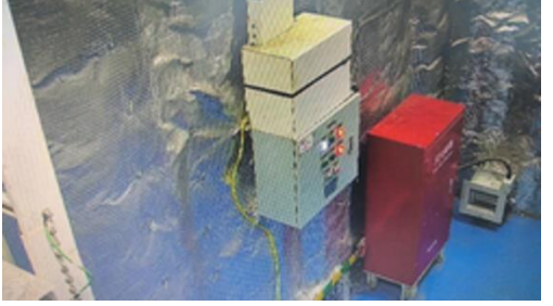
升压站主变压器室内墙体敷设外壳为铝合金的吸音板
